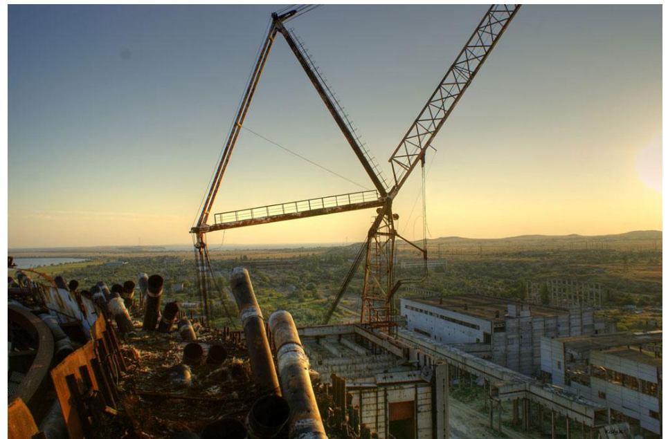
Obr. 34: Pohled z budovy reaktoru [21].
