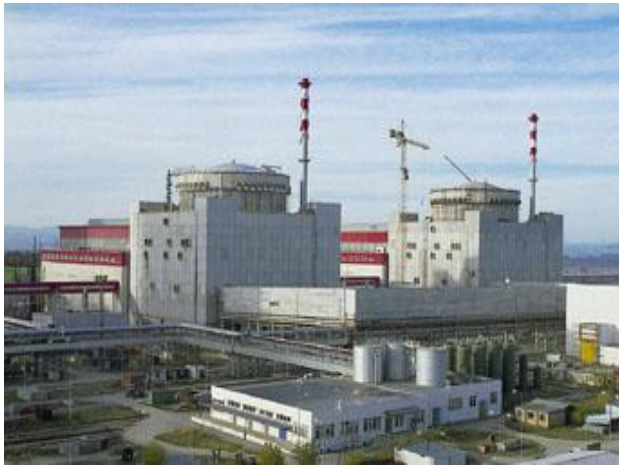
Obr. 22: Stavba JE Temelín (90.léta) [14,15].
